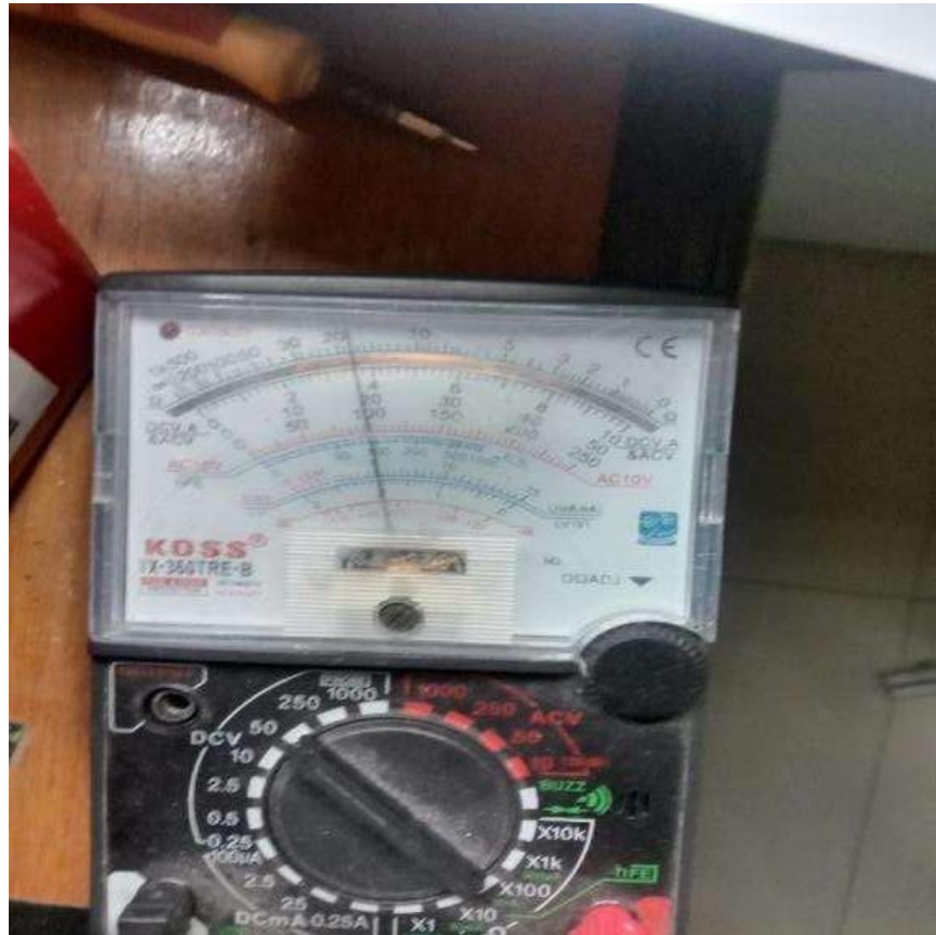
Gambar 4. 4 Pengukuran Tegangan Output Panel Surya Sumber : Penulis, 2021
