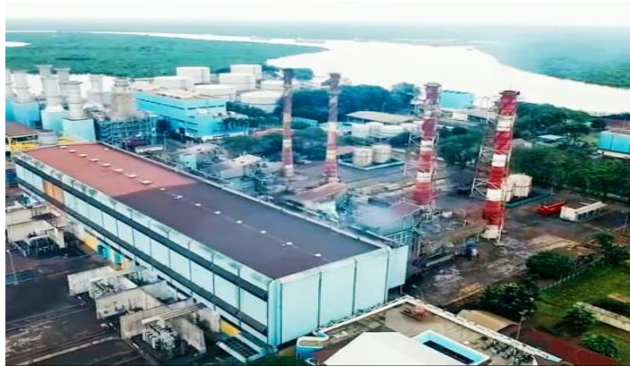
Gambar 2.32 PLTU UPK Belawan
