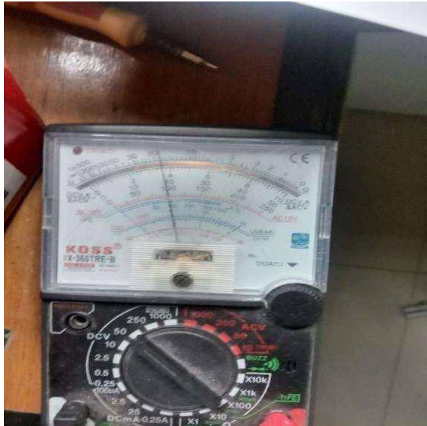
Gambar 4. 4 Pengukuran Tegangan Output Panel Surya Sumber : Penulis, 2021
