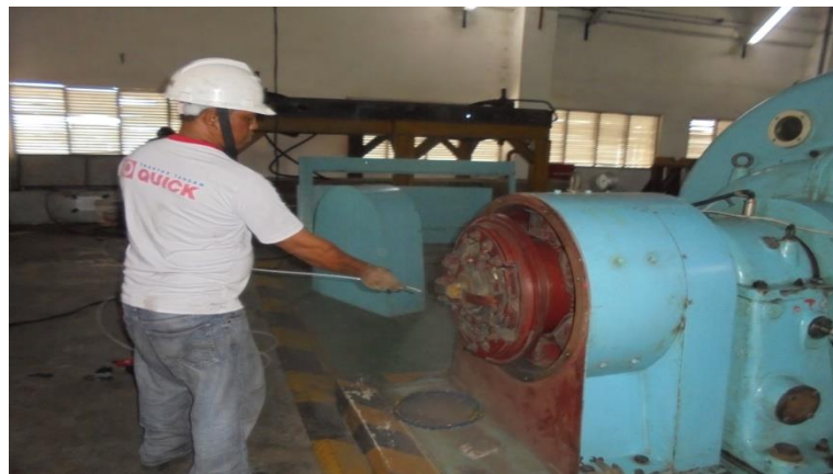
Gambar 2.17 Cleaning Exciter dengan Nitrogen PT. Soci Mas
