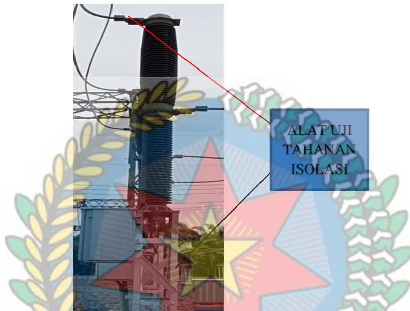
Gambar 2.14 Rangkaian pengukuran atas - ground Sumber : penulis 2022
