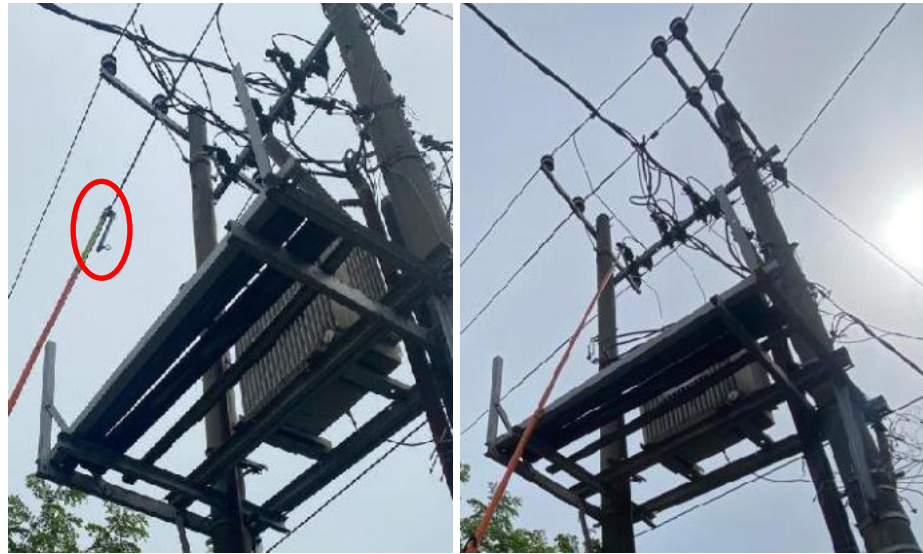
Gambar 3.18 Pemasangan Di Gardu Distribusi BR 202 Penyulang LS 05
