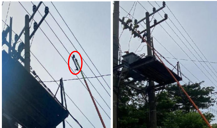
Gambar 3.19 Pemasangan Di Gardu Distribusi BR 390 Penyulang GL 03
