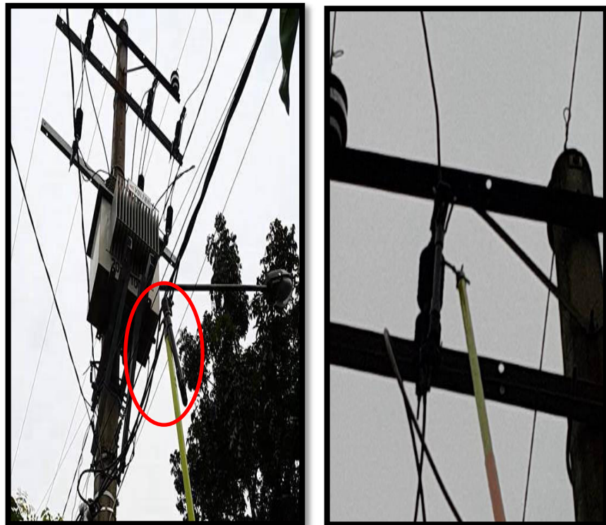
Gambar 3.17 Pemasangan Di Gardu Distribusi BR 241 Penyulang GL08
