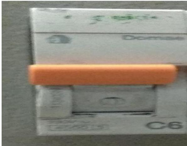
**Gambar 3.2 Miniatur Circuit Breaker Untuk Motor Penggerak Palang**
