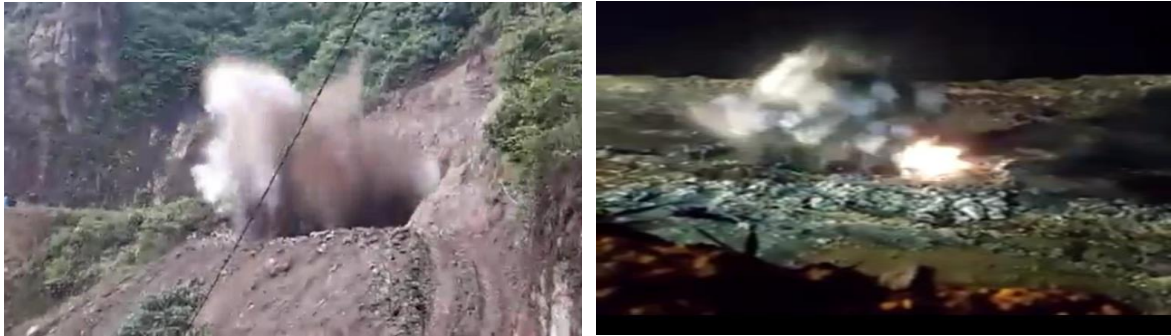
Dokumentasi: Pengeboman dalam pembuatan Pndasi Bendungan Lau Simemei di badan Sungai Lau Seruai.
