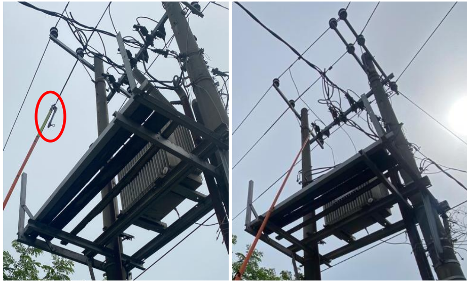
Gambar 3.18 Pemasangan Di Gardu Distribusi BR 202 Penyulang LS 05
