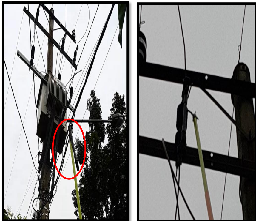
Gambar 3.17 Pemasangan Di Gardu Distribusi BR 241 Penyulang GL08
