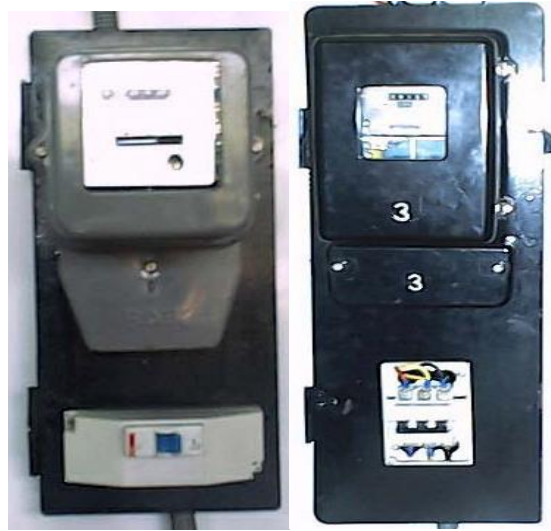
Gambar 2.28 KWH Meter 1 Fasa dan 3 Fasa Sumber: Materi Pembelajaran Udiklat Tuntungan, 2016
