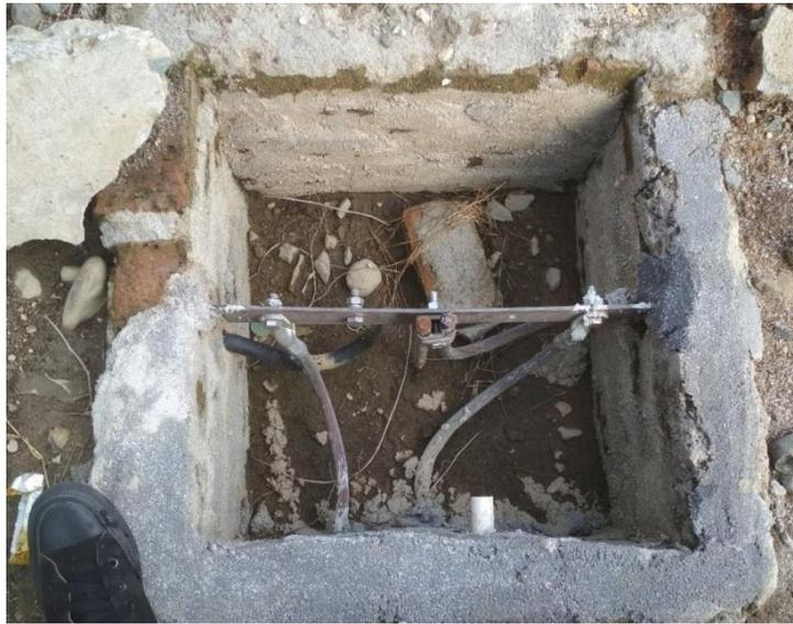
**Gambar 3.8** *Grounding Root dan Grounding Mesh Setelah Dipasang dan Ditambah Busbar Grounding Untuk Penggabungannya*
