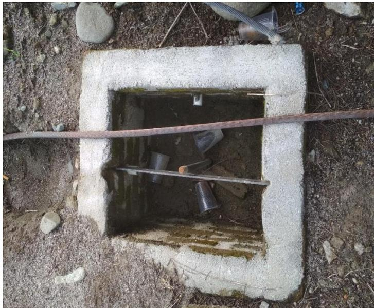
**Gambar 3.7** *Stick Grounding Root* dan *Grounding Mesh* Sebelum Dipasang
