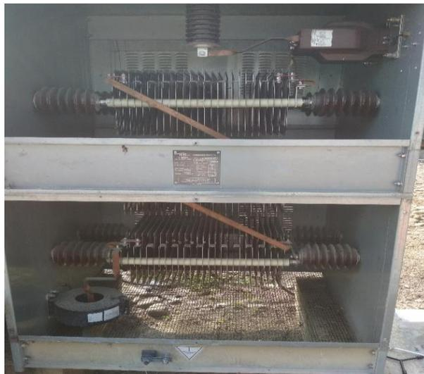
**Gambar 2.13 Bentuk Fisik Rangkaian *Neutral Grounding Resistance* Jenis Metal**
