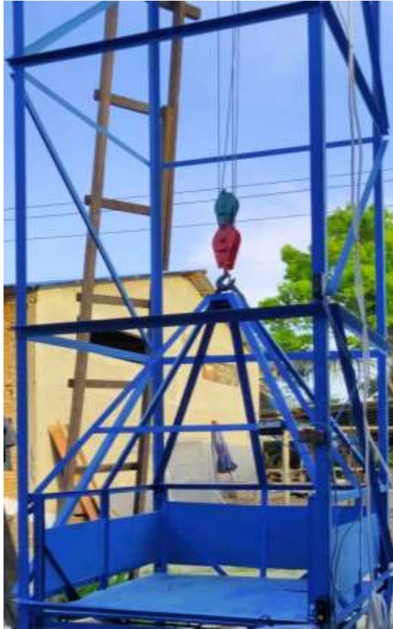
Gambar 2. 5 Hoistway dan Rel
