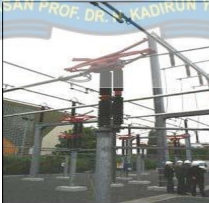
Gambar 2.27. Pemisah Pantograph.
