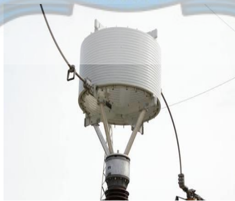
Gambar 2.29. Wave Trap atau Line Trap.
