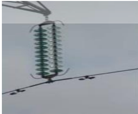
Gambar 2.32. Isolator Tonggak Saluran Vertikal Sumber: Agung Tri Pamungkas, 2013
