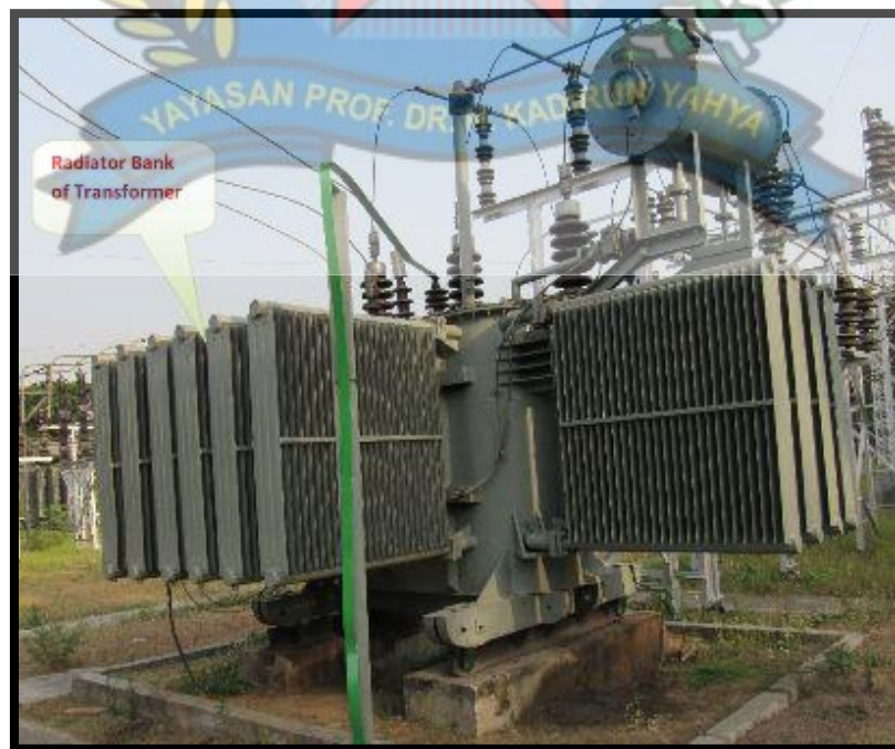
Gambar 2.7 Radiator Trafo
